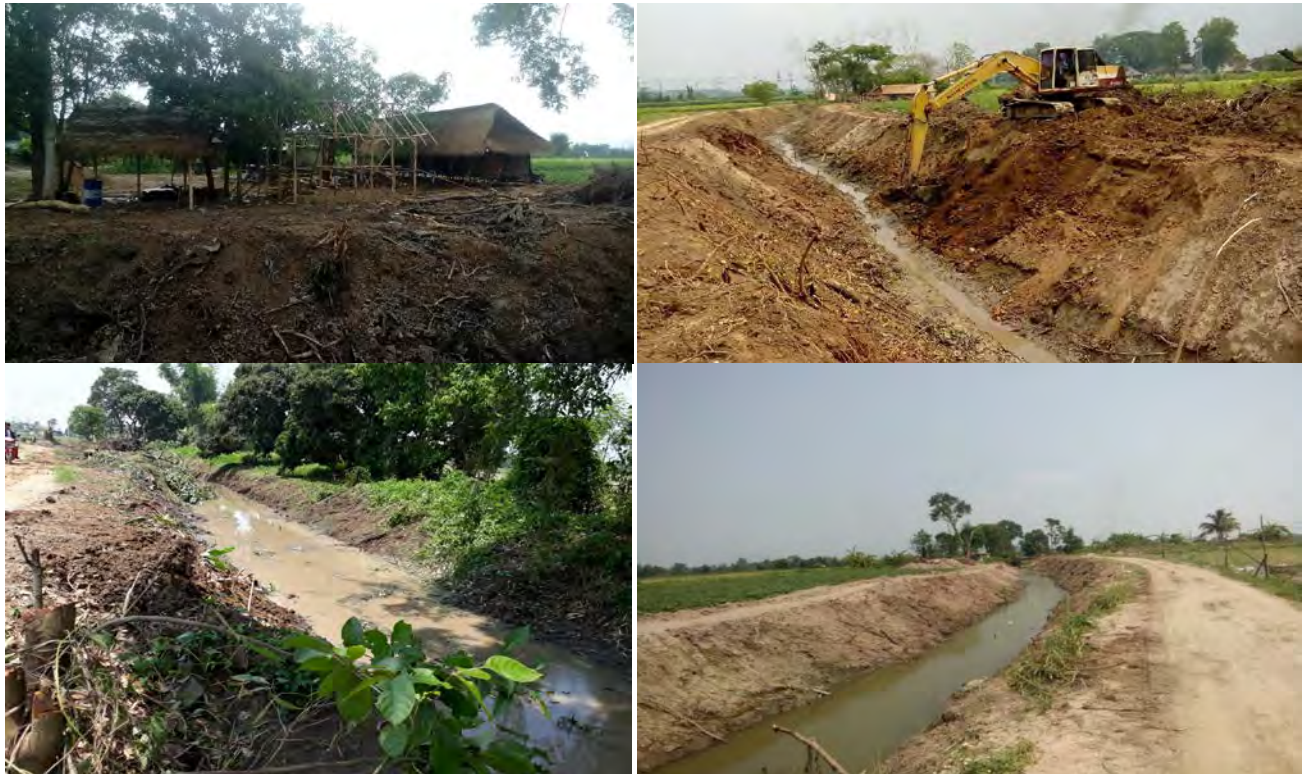
แผน - ผลปฏิบัติงานก่อสร้าง โครงการก่อสร้าง สำนักงานชลประทานที่ 1 ปรับปรุงระบบส่งน้ำฝายรูบัววน สนับสนุนพื้นที่เกษตรแปลงใหญ่ ตำบลสันทราย อำเภอฝาง จังหวัดเชียงใหม่
