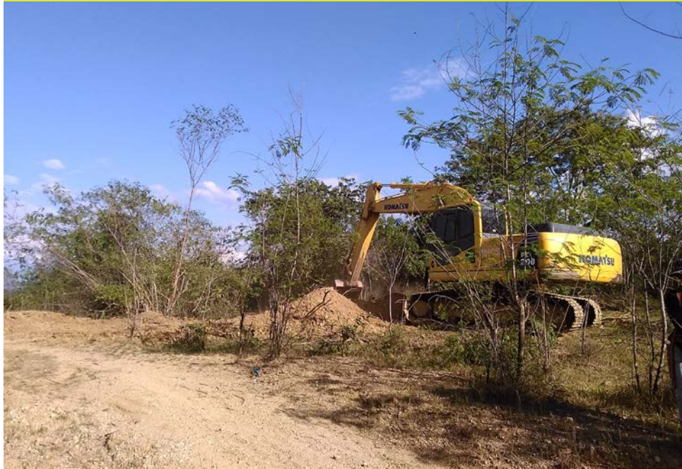
งานขุดป่าถางต่อไม้ เพื่อปรับพื้นที่สร้างแคมป์
