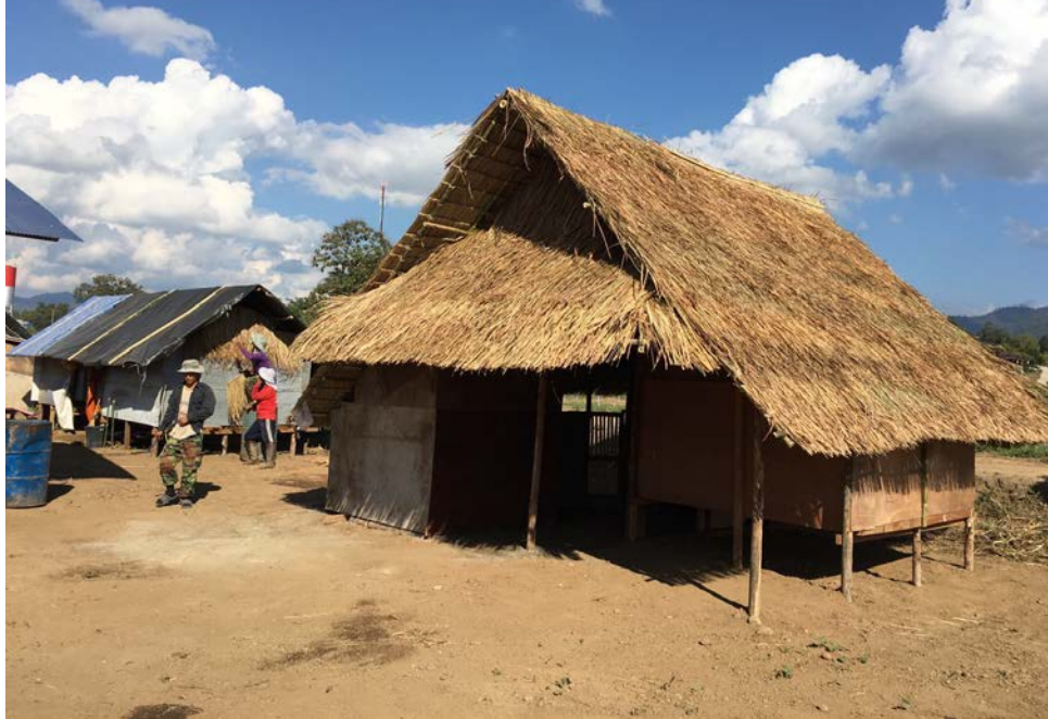
งานก่อสร้างแคมป์
