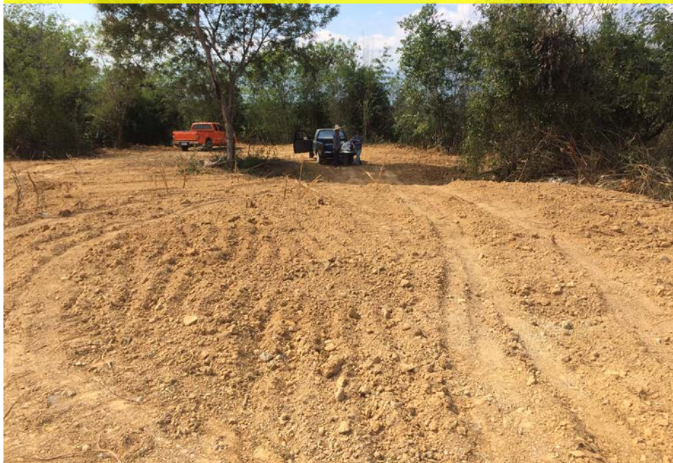
งานขุดป่าถางต่อไม้ เพื่อปรับพื้นที่สร้างแคมป์
