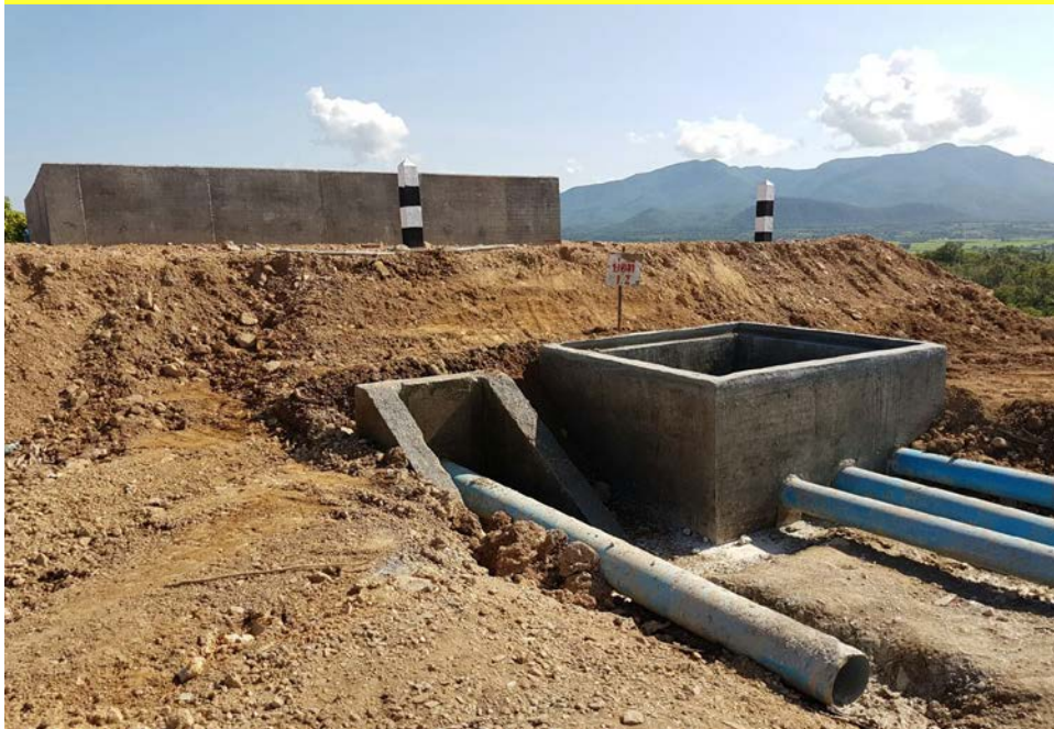
ความก้าวหน้าระบบส่งน้ำอ่างเก็บน้ำห้วยโทก (บ่อพักน้ำที่ 12)
