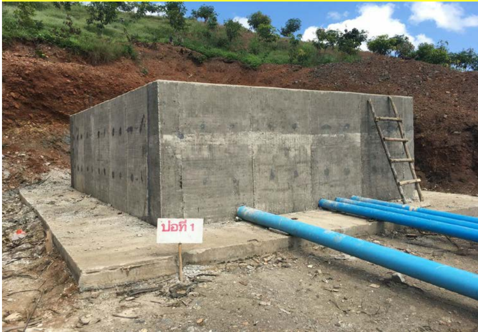
ความก้าวหน้าระบบส่งน้ำอ่างเก็บน้ำห้วยโทก (บ่อพักน้ำที่ 1)
