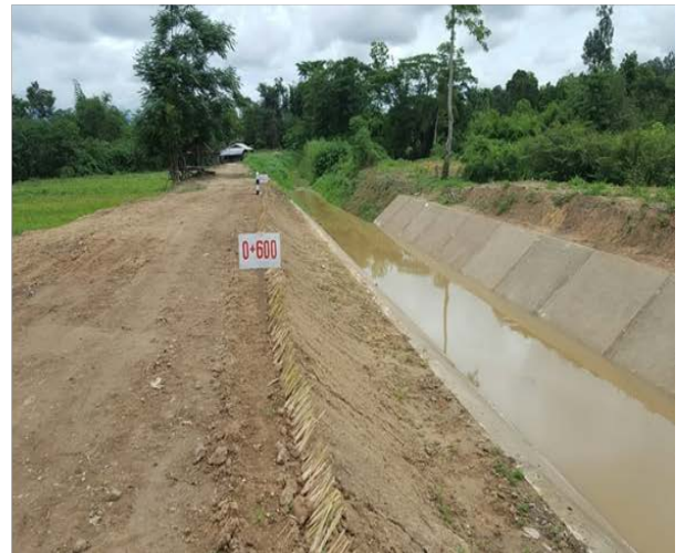
หลังดำเนินการก่อสร้าง
