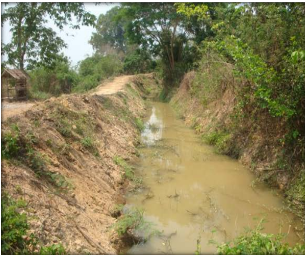
ก่อนดำเนินการก่อสร้าง
