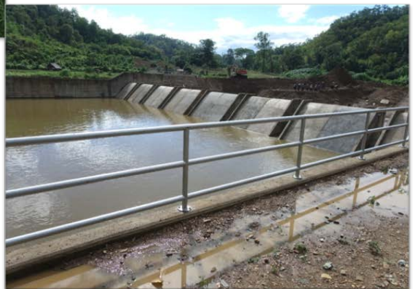
รูปถ่าย ก่อนดำเนินการก่อสร้าง และ หลังดำเนินการก่อสร้าง
